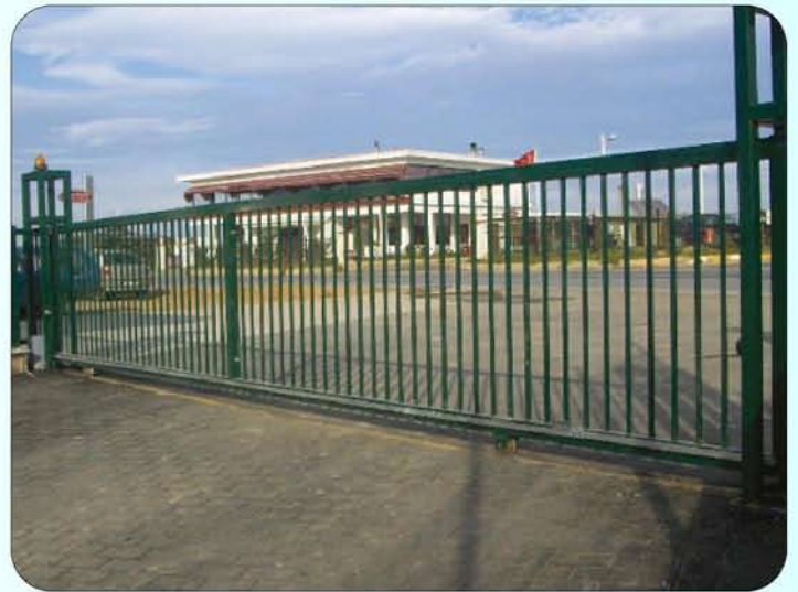
Raylı Kapı Uygulanması / Rail Gate Application
