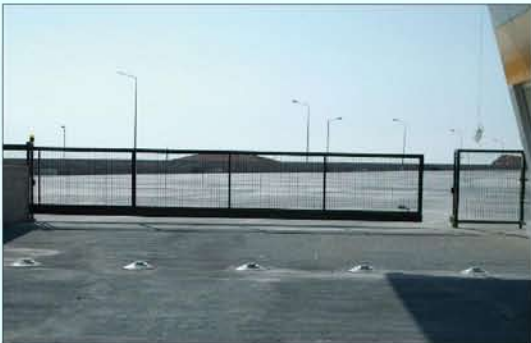
Hidrolik Grup Mantar Bariyer / Hydraulic Bollard Group
