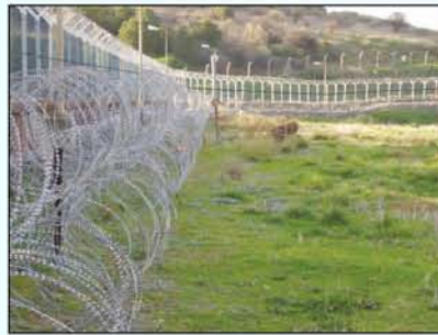
Tel Üstü Algılama ve Üç Sıra Helezonik Jiletli Tel Uygulaması Sensor Cable And 3 Rows Concertina Razor Wire Application
