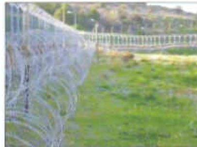
Tel Üstü Algılama ve Üç Sıra Helezonik Jiletli Tel Uygulaması Sensor Cable And 3 Rows Concertina Razor Wire Application
